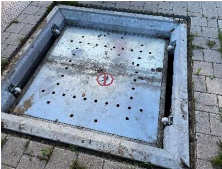
Abb. 20 Sicherheitsplattform Behälterschacht
