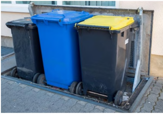
Abb. 6 Beispielbilder Versenkbarer Behälterstandplatz (Stadtentsorgung Rostock)
