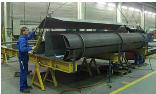
Optimierte Produktionsabläufe durch Vorfertigung von Teilen außerhalb des Gehäuses.
