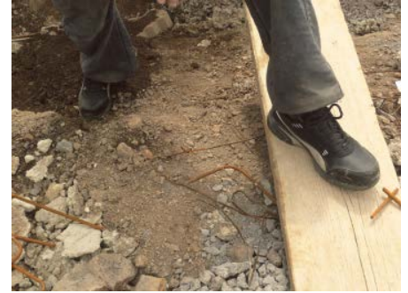
Abb. 2: Fixierung mittels Schnürung
