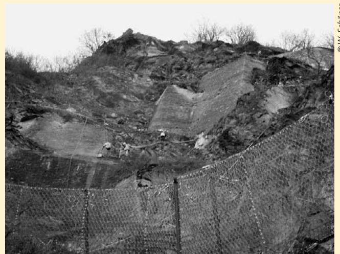
Abb. 3: Ausführung von Felshangssicherungsarbeiten.
