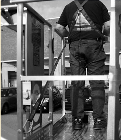
Abb. 4: Sicherung mit PSA gegen Absturz im Arbeitskorb.
