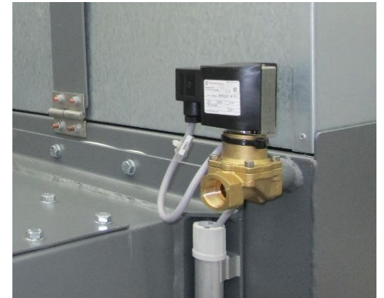
Bild 2: H2-Entgasungseinrichtung am Abscheider
