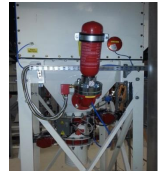
Bild 2: Bsp. Explosionsunterdrückung an einem Trockenabscheider
