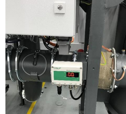
Bild 1 u. 2.: Beispiele Überwachung Mindestvolumenstrom Quelle: CHIRON-WERKE
