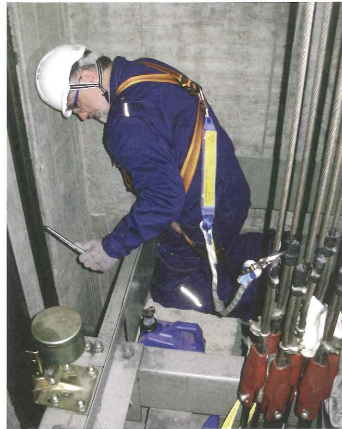
Bild 2 Ein temporärer Anschlagpunkt erfordert besondere Nachweise.
