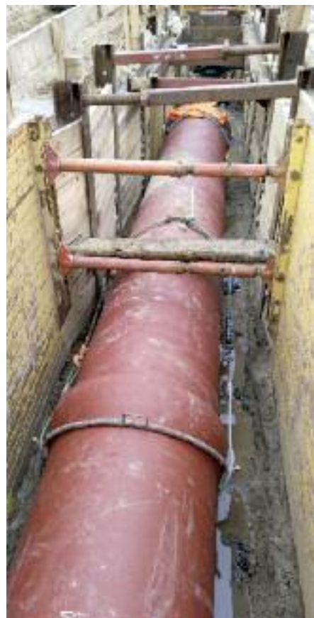
Abb. 1: Rohrleitung mit Kettenzug zusammengezogen
