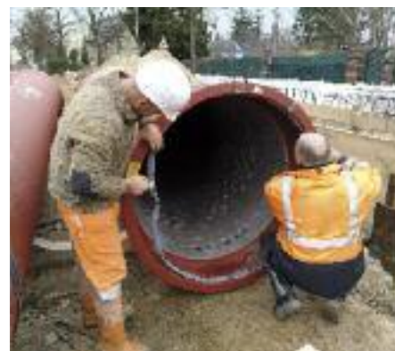
Abb. 2: Montage des Dichtungsringes zur Simulation der Arbeitsraumbreite außerhalb des Grabens
