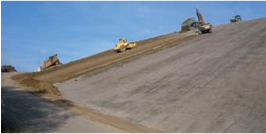
Abb. 2: Einbau der mineralischen Dichtung
