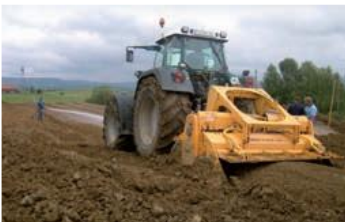
Abb. 3: Traktor mit Anbaufräse zur Vorbehandlung der mineralischen Dichtung
