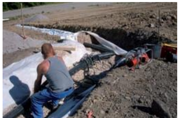
Abb. 4: Herstellen einer Rohrleitungsverbindung
