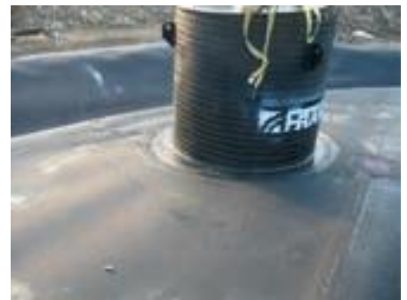
Abb. 5: Einbindung eines Schachtes in die Kunststoffdichtungsbahn
