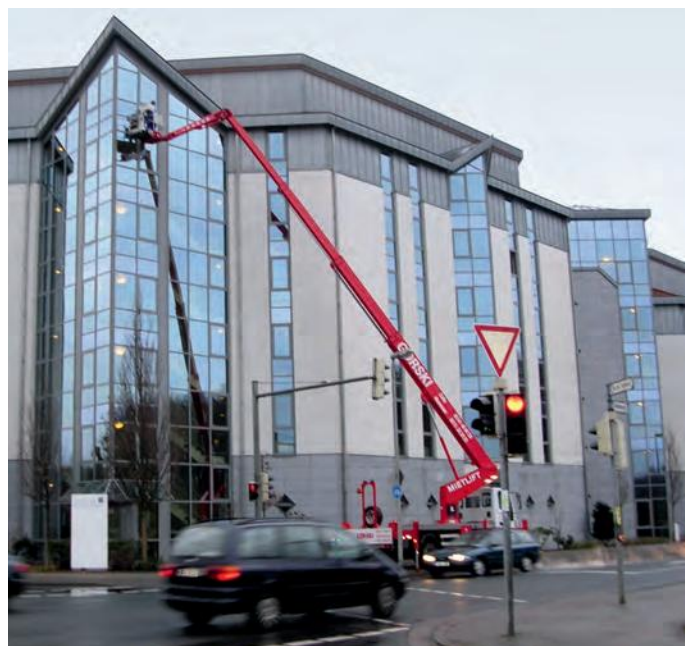
Abb. 3: Reinigen mit Hubarbeitsbühne
