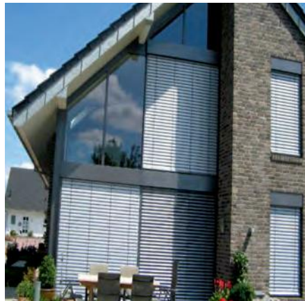
Abb. 1: Schwere Unfall beim Reinigen des Dreiecksfensters
