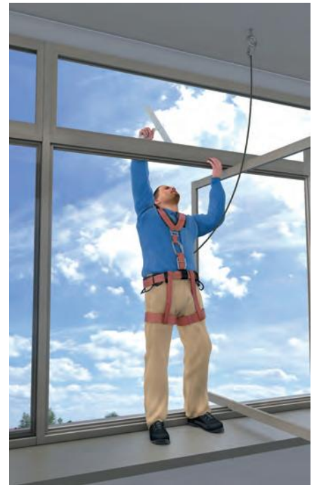
Abb. 10: Anseilsicherung mit Anschlagssystem
